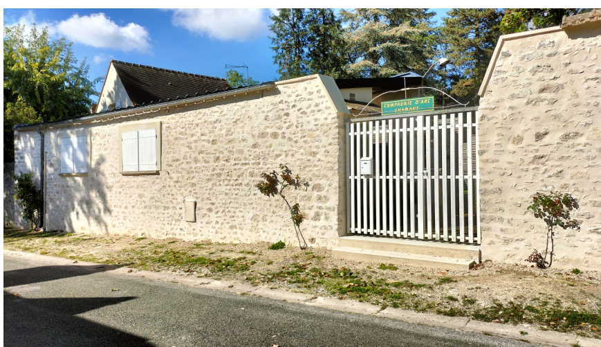
Merci à la Commune de Chamant pour les travaux de rénovation de notre Compagnie d'Arc
